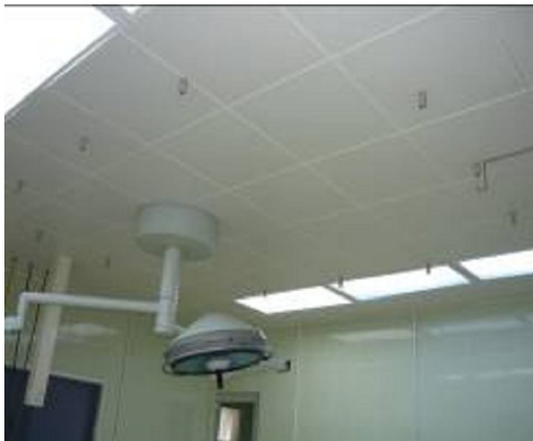
Hệ thống 09 ống phun khí siêu sạch áp lực dương
