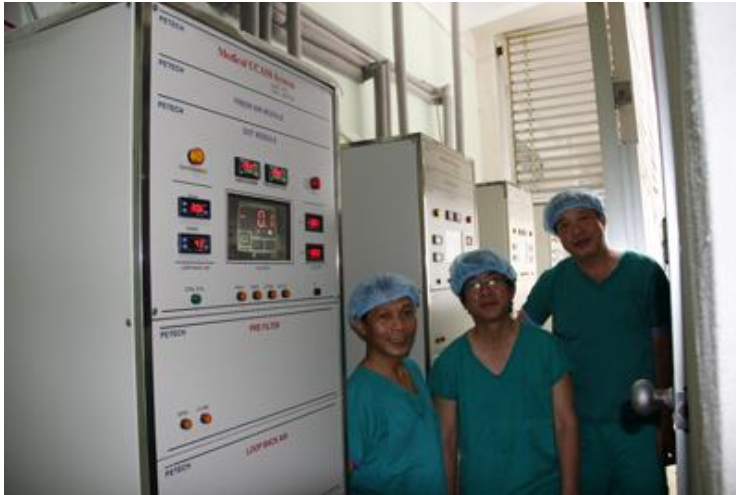
Hệ thống cấp khí siêu sạch UCASS - X7G đầu tiên do Việt Nam chế tạo, lắp đặt tại BV Chợ Rẫy TPHCM.
