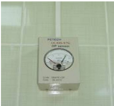
Đồng hồ DP Sensor đo áp lực dương đầu phun khí , độc lập với hệ thống UCASS
